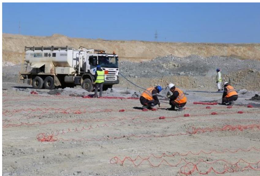
Рисунок 4 – Взрывники устанавливают заряды на карьере Актогай
